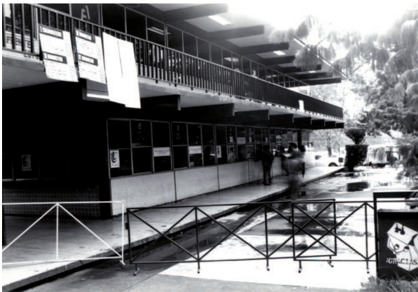
Parte posterior del edificio "A"
